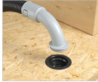
Aufstecken des 90°-Bogens auf das Elektroinstallationsrohr und ...
