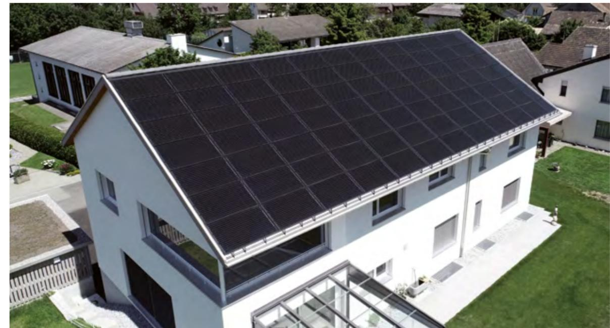
Blindlaminate ermöglichen den ästhetisch stimmigen Abschluss und die einheitliche Nutzung des Dachs trotz Störobjekten wie Kamine oder Abluftröhre.
