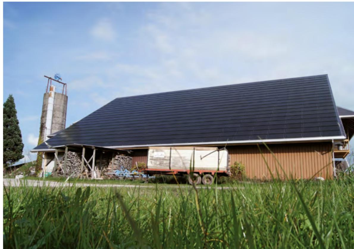
Die Blindlamine auf der rechten Dachseite ermöglichen eine gute Anpassung an die Dachgrösse.
