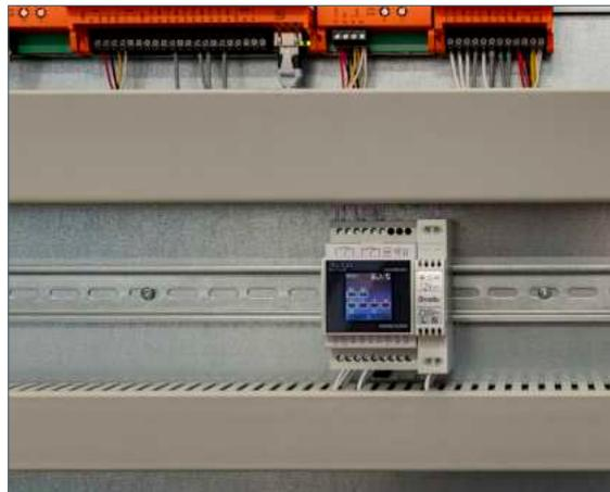
**4G Fernschalt- und Überwachungsmodul switchButler**
